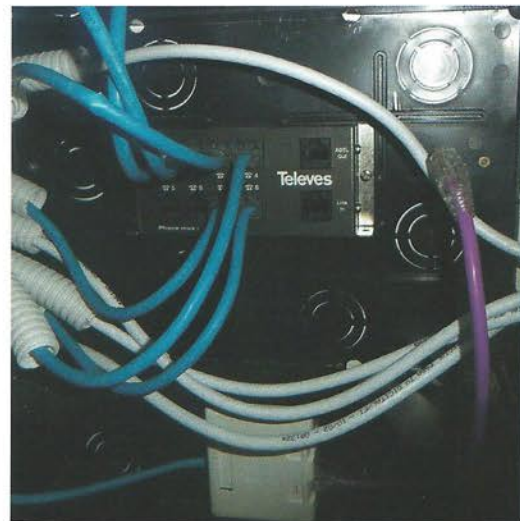
Figura 7.12. Multiplexor pasivo.
