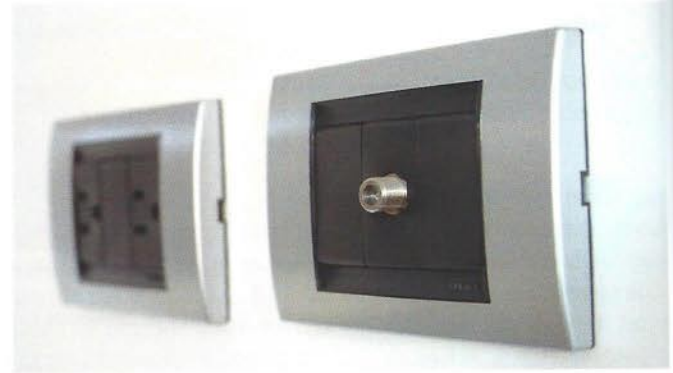
Figura 7.15. BAT para la red de cables coaxiales.
