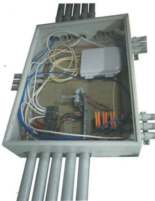
Figura 7.8. Ejemplo de punto de distribución.
