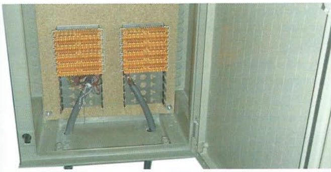
Figura 7.20. Ejemplo de punto de interconexión de la red de pares.
