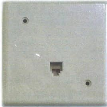
Figura 7.60. BAT del servicio de telefonía.
