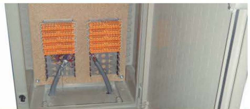
Figura 7.20. Ejemplo de punto de interconexión de la red de pares.
