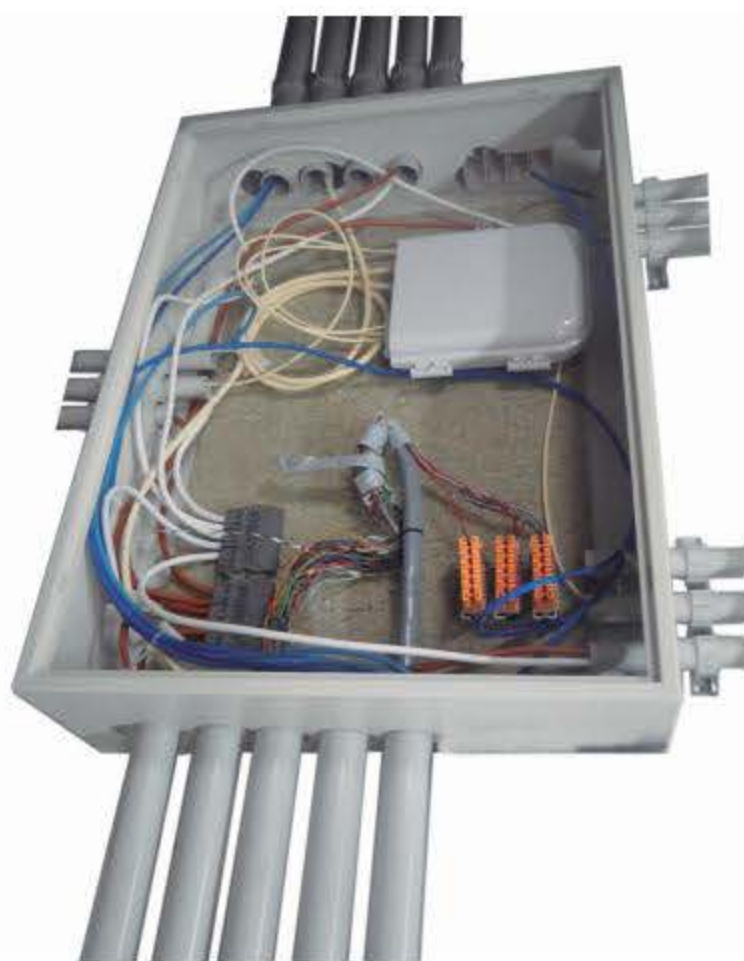
Figura 7.8. Ejemplo de punto de distribución.
