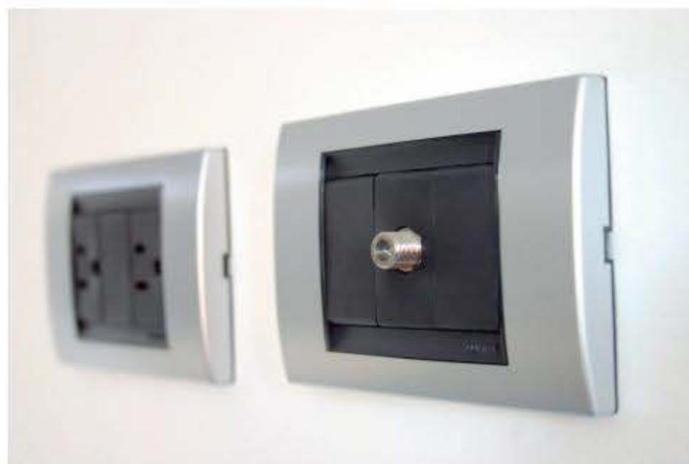
Figura 7.15. BAT para la red de cables coaxiales.
