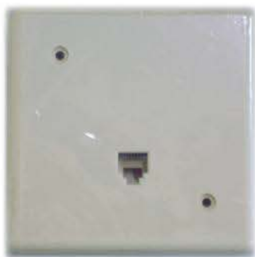
Figura 7.60. BAT del servicio de telefonía.
