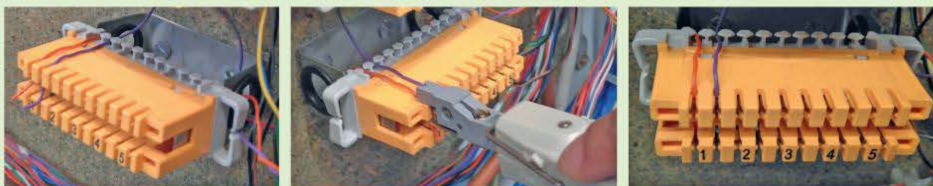
Figura 6.27. Conexión del cable de pares en una regleta.
