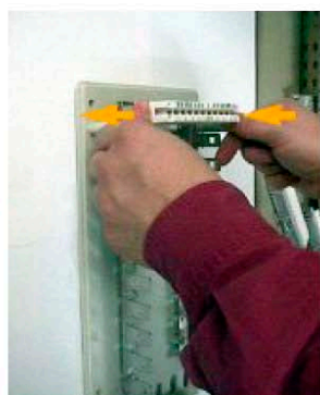
Colocación de las regletas.
