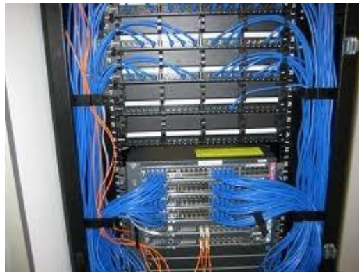
Figura 5-6. Ejemplo de recogida del cable sobrante en forma de coca
