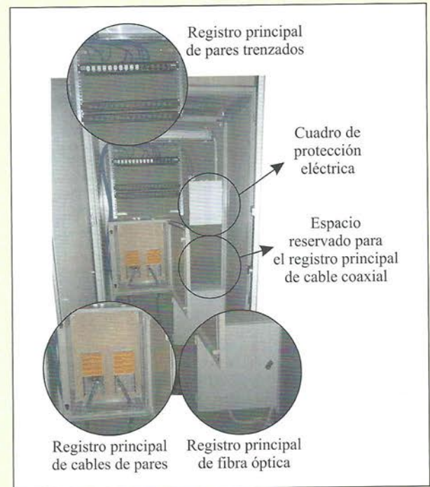
Figura 8.27. Registros principales en el interior del RITI modular didáctico.
