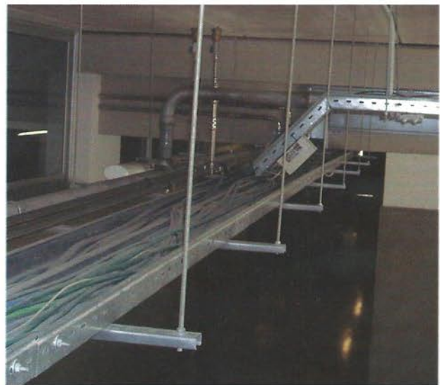
Figura 8.10. Ejemplo de instalación mediante bandejas.
