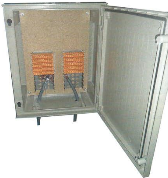
Figura 8.26. Registro principal de la red de pares.
